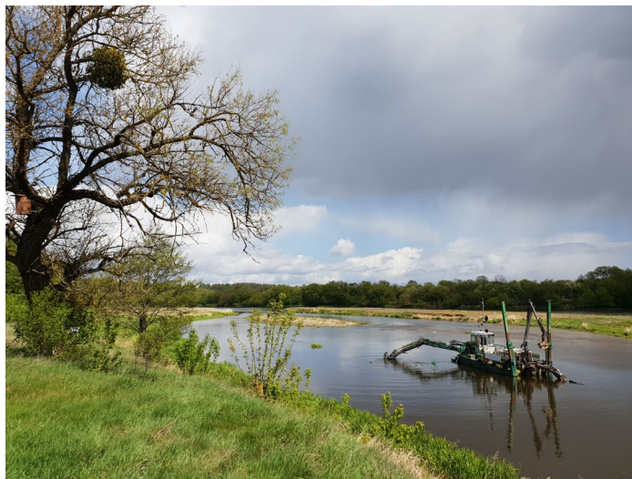
3.5 pav. Nemuno upės vagos ties Lipliūnų kaimu valymo darbai.
